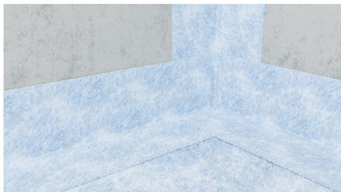
La membrana di tenuta può essere sovrapposta per 5 cm utilizzando il collante di tenuta nella zona di sovrapposizione. Altrimenti, le giunzioni possono essere coperte con un nastro di tenuta e materiale sigillante. Mescolare l'adesivo di tenuta e applicarlo sulla membrana impermeabilizzante con una spatola dentata adatta. A questo punto è possibile iniziare a piastrellare senza ulteriori attese.
