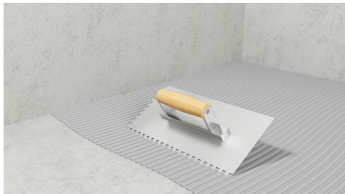
Applicare la membrana sigillante sul terreno in modo preciso e da bordo a bordo, lisciandolo verso i bordi. Evitare inclusioni d'aria e residui di colla!
