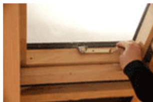
Le système spécial de poignée offre la possibilité de 2 positions d'ouverture pour la ventilation ; la poignée ne dépasse pas dans le compartiment et reste toujours dans l'espace du cadre.
