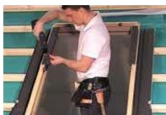
Fixation des éléments latéraux de l'armature :
