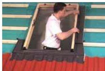
Pose des éléments latéraux de la connexion.
